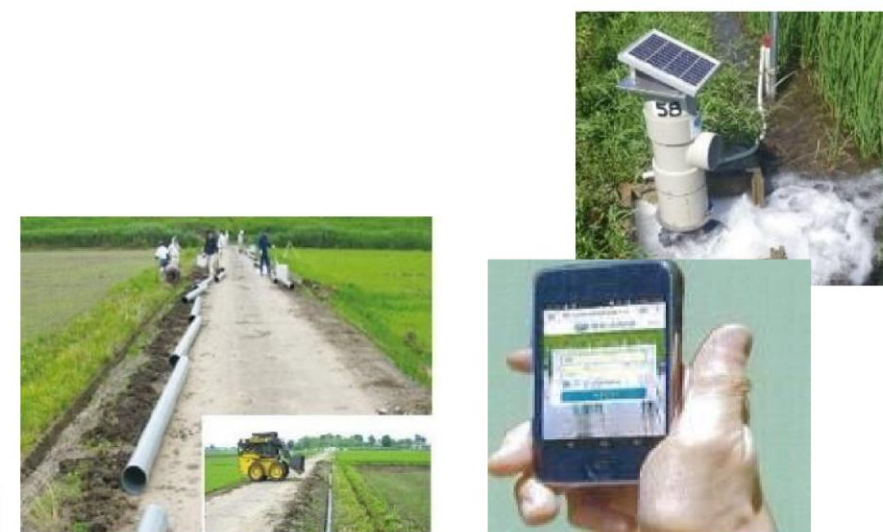
水路の管路化
