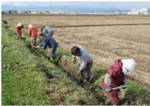
水路の泥上げ
